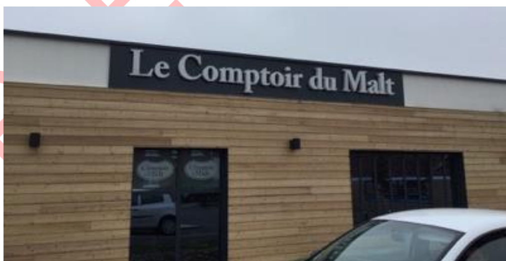
Enseignes parallèles au mur jouant sur le contraste, rue de l'Abregain, novembre 2018
